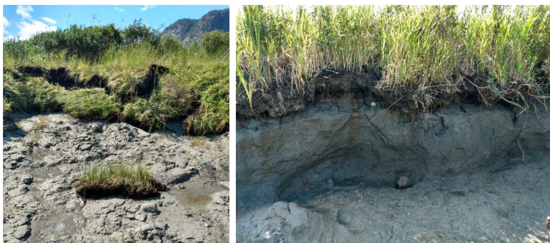
Photographie 8. Morceaux se détachant de la microfalaie du schorre supérieur.
