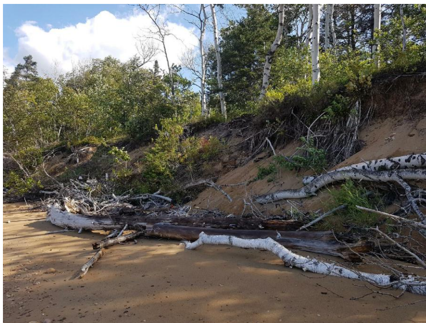
Photographie 14. Talus érodé situé dans la zone du marais ouest (zone 2).
