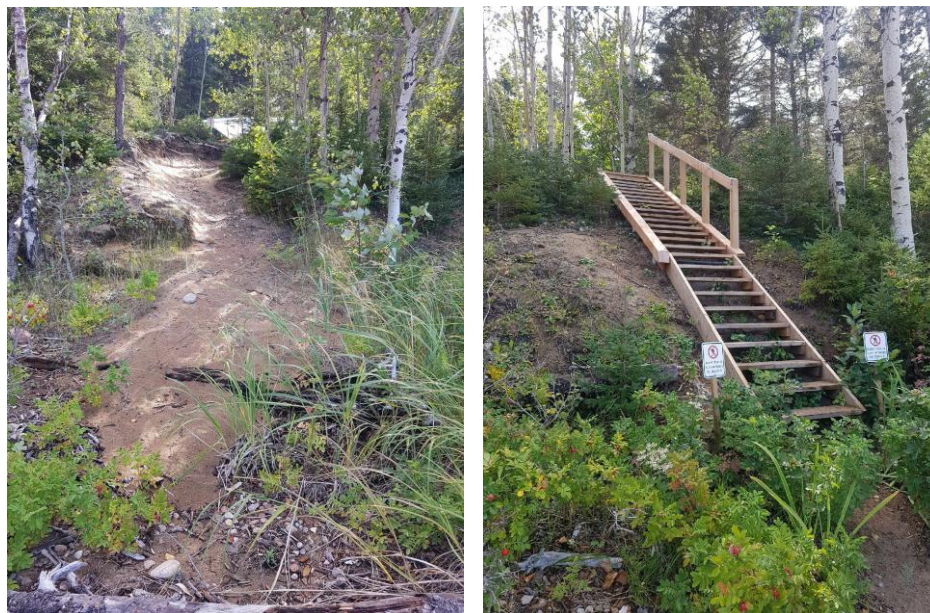
Photographie 15. Chemin illicite du camping vers la plage et escalier construit afin de pallier ce problème.
