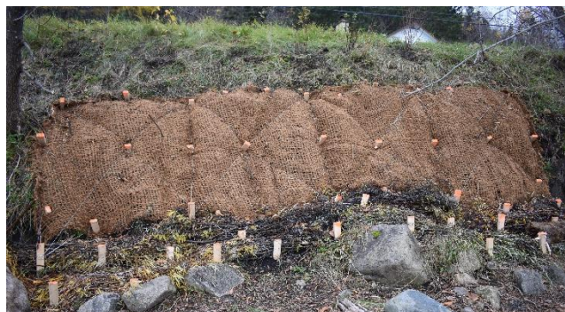
Figure 2. Matelas de branches de saule à l'Anse Saint-Jean avec géotextile tissé biodégradable et fascine à sa base
