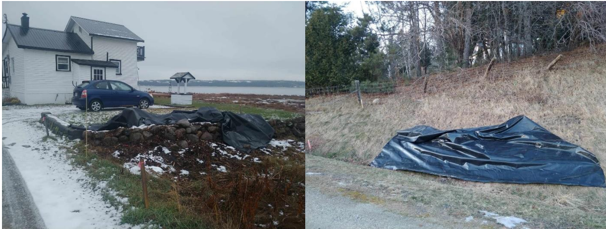
Figure 4. Membranes géotextiles déplacées (#24 et #91A).
