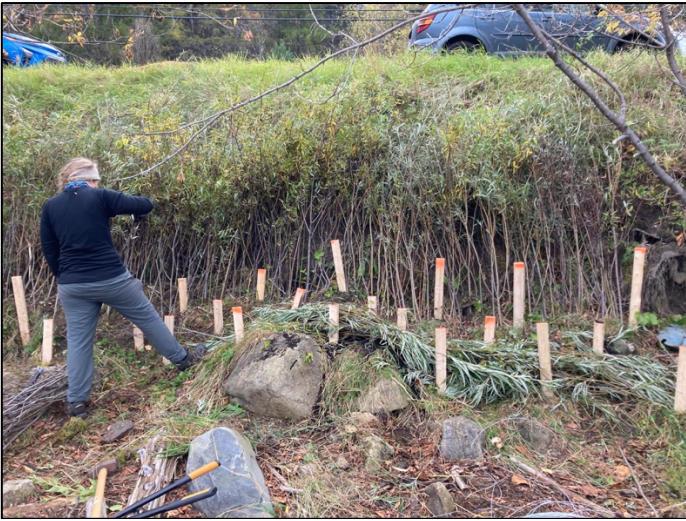
Figure 34 Fascines et tiges pour matelas avant l'installation de la membrane Secteur 3
