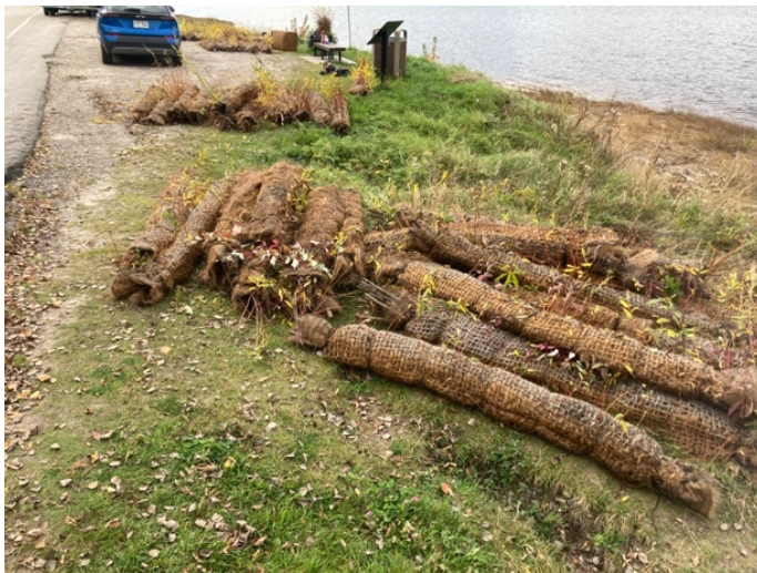
Figure 16 Boudins prévégétalisés conçus par l'entreprise AFFM
