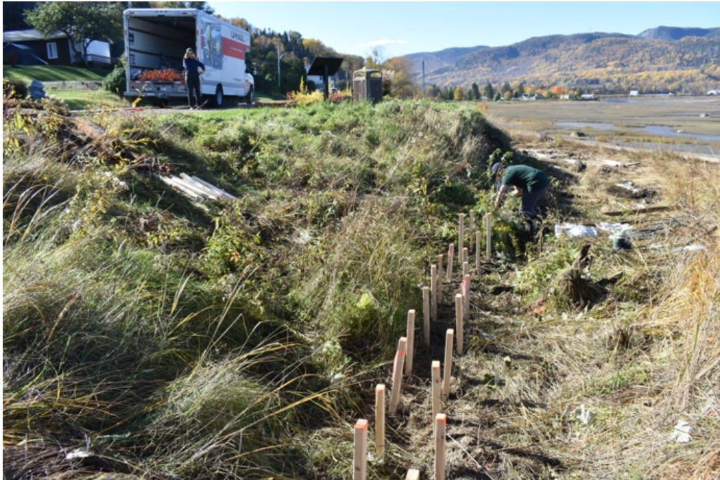
Figure 15 Installation des piquets et fabrication des fascines de saules
