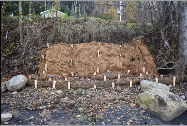
Figure 18 Matelas de branche et boudins Secteur 1 (1) Figure 19 Matelas de branche et boudins Secteur 1 (2)
