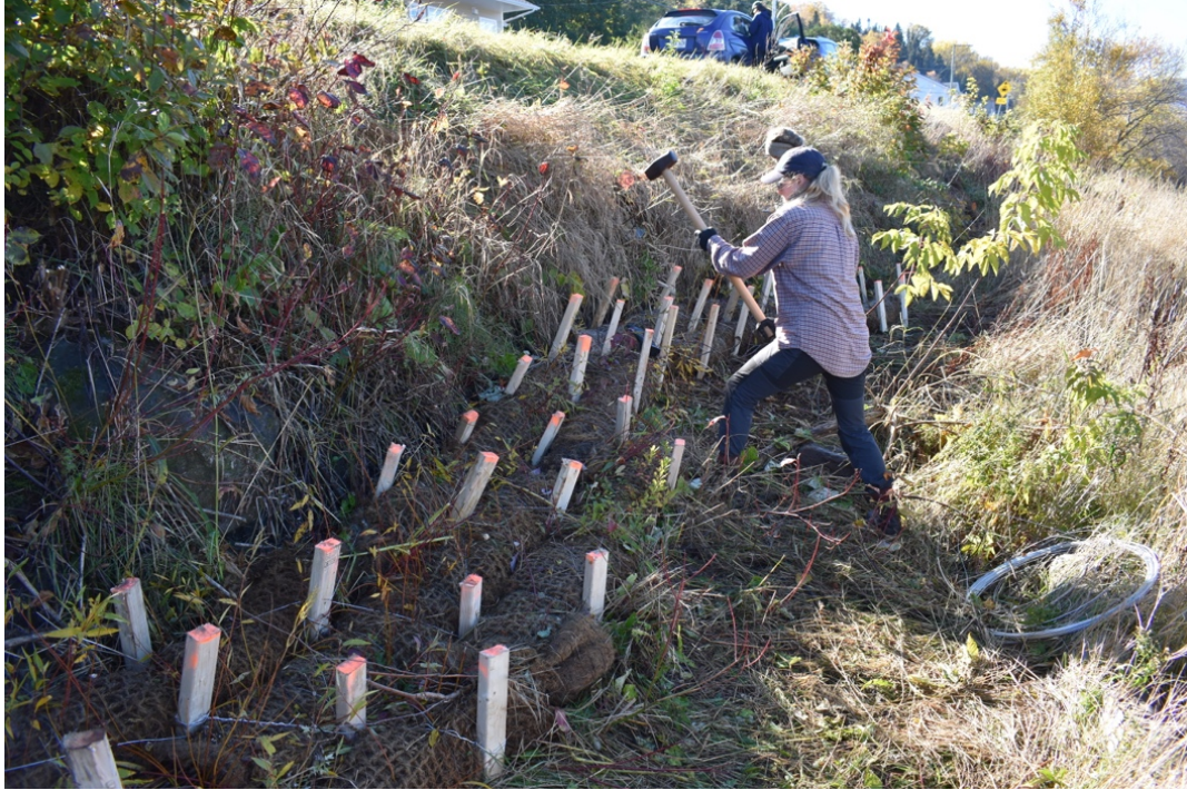
Figure 17 Installation de boudins prévégétalisés au pied de la berge
