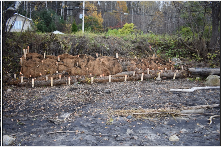
Figure 18 Matelas de branche et boudins Secteur 1 (1) Figure 19 Matelas de branche et boudins Secteur 1 (2)
