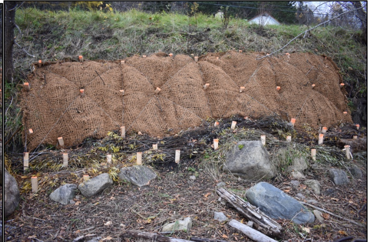
Figure 35 Boudins et Matelas de branches Secteur 3 (1) Figure 36 Boudins et Matelas de branches Secteur 3 (2)
