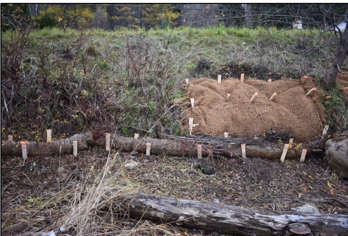
Figure 35 Boudins et Matelas de branches Secteur 3 (1) Figure 36 Boudins et Matelas de branches Secteur 3 (2)
