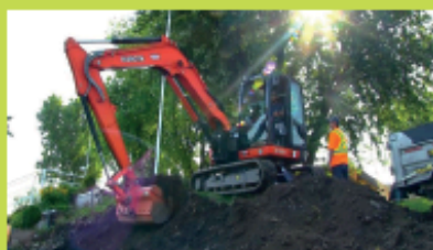
▲ Excavatrice mécanique © Dropt Lortie
