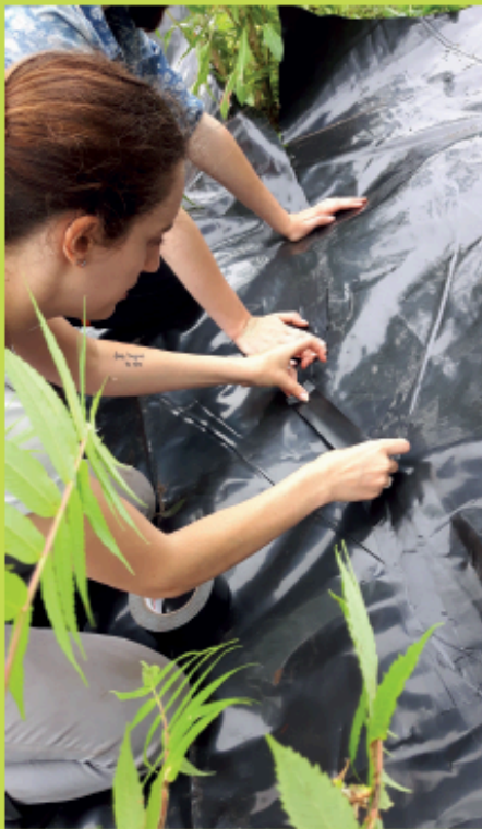
▲ Réparation d'une géomembrane © Collège ZIP Jacques-Cartier
