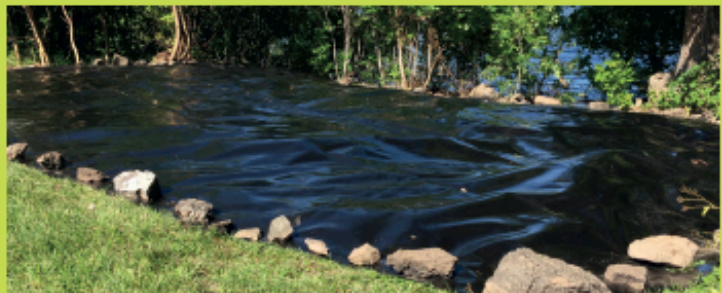
▲ Géomembrane installée © Comité ZIP des Saguenais
