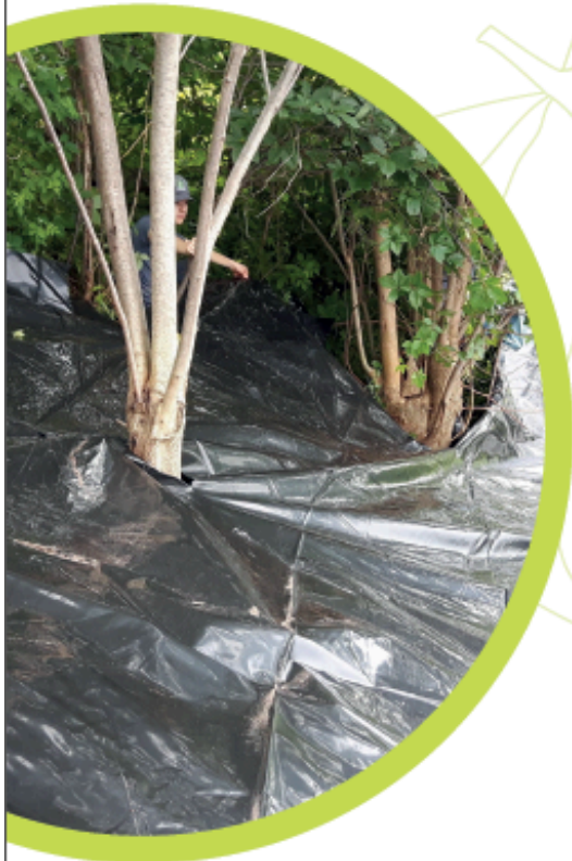
▲ Géomembrane installée © Comité ZIP Jacques-Cartier
