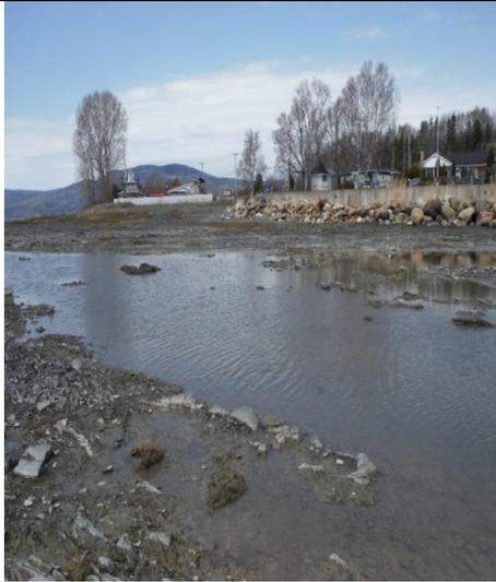
Figure 47 : L'enrochement et le mur de béton empêche tout apport de substrat propice à la fraie
