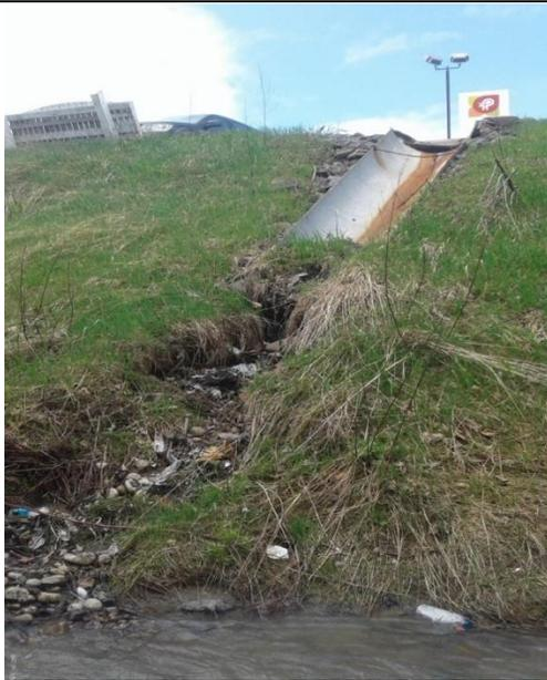
Figure 15 : Énormément de déchets apportés vers le cours d'eau par les eaux de drainage du stationnement
