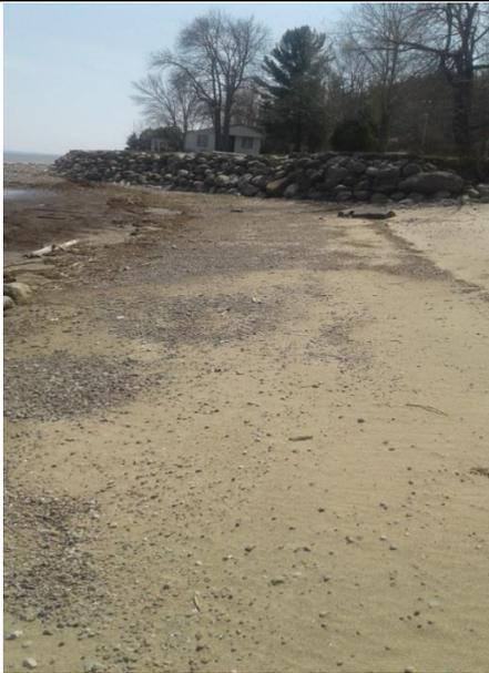
Figure 41 : enrochement contrôlant l'érosion de la berge
