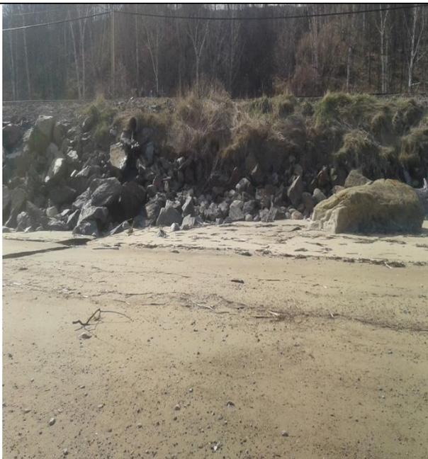
Figure 39 : Enrochement de la berge prévient l'érosion des berges ce qui peut nuire à la recharge de la plage
