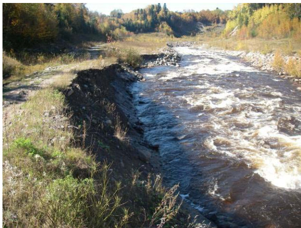
Photo 69 : Zone d'érosion (RA19)
