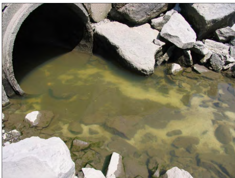
Figure 25. Débordement de conduite unitaire, Chicoutimi-Nord.
