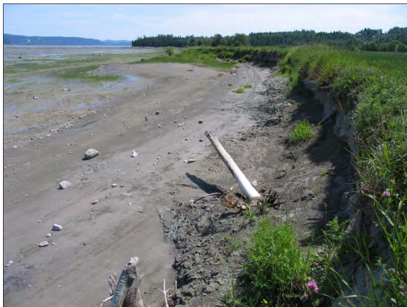
Figure 16. Érosion majeure en milieu agricole, rang Saint-Martin.
