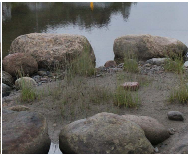
Photo 14 : Enrochement après la plantation
