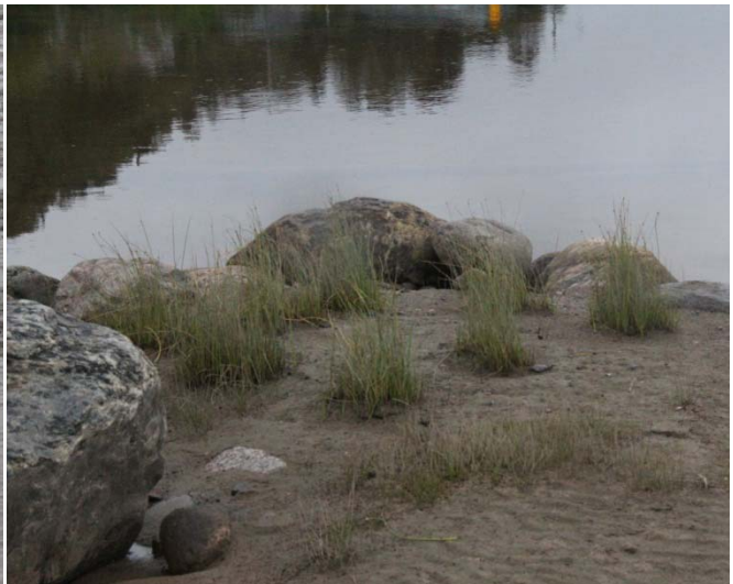
Photo 12 : Enrochement après la plantation
