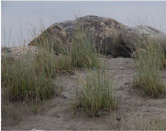
Photo 13 : Enrochement après la plantation
