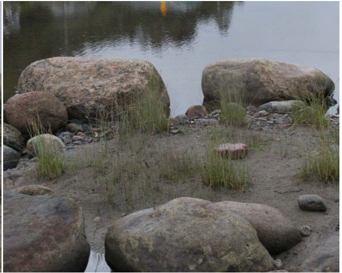
Photo 14 : Enrochement après la plantation
